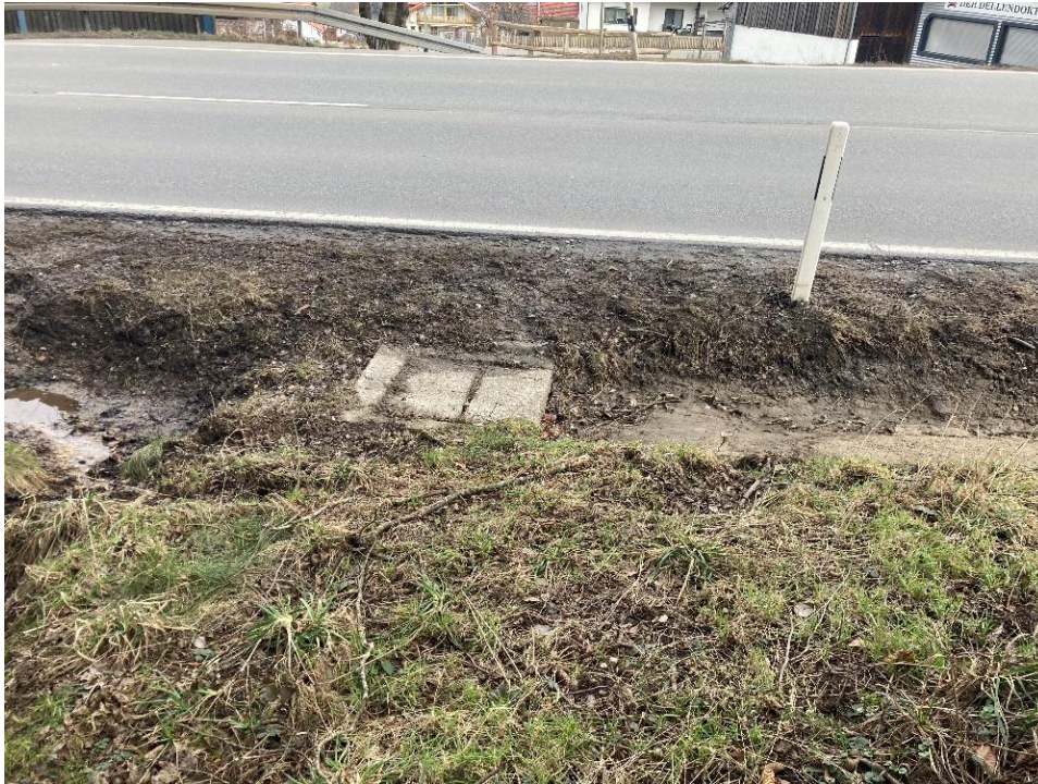
Abbildung 4: Einlaufbauwerk Durchlass B85
